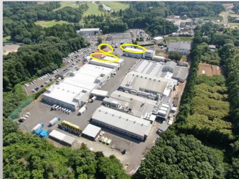
[茨城工場(黄色い丸がパネル設置予定箇所)]
